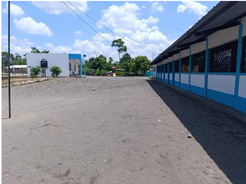
Foto 2: Fotografía donde se evidencia que no existen canales de recolección de Aguas Lluvias en los Bloques de aulas de Unidad Educativa "24 de Octubre".
